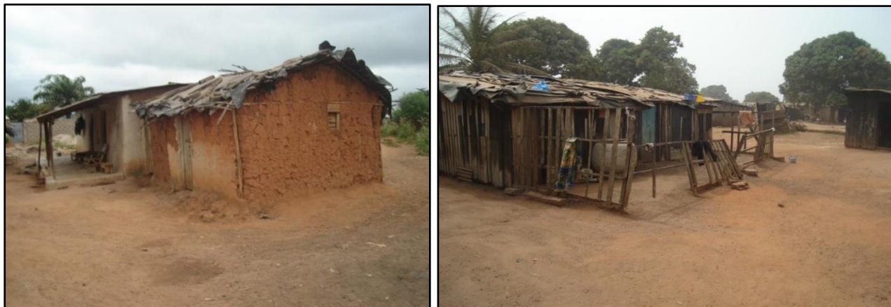
Planche photo 2 : Habitat précaire au quartier Tazibouo 2 et Orly 2
