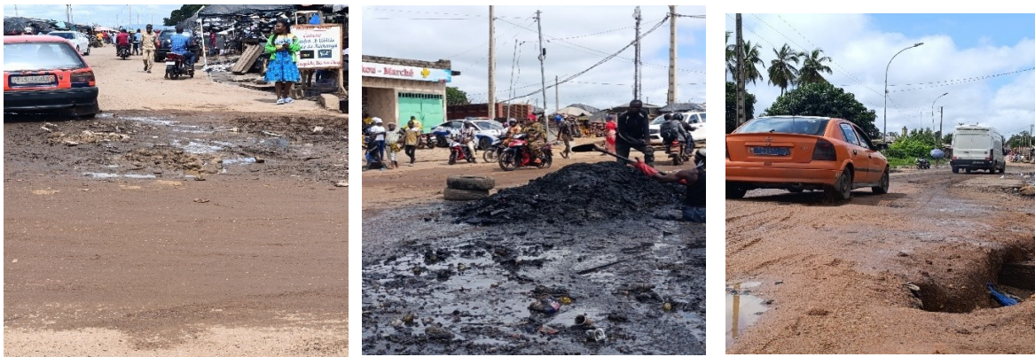
Photo 1, 2 et 3 : Principaux axes routiers dégradés dont voie principale du grand marché et voie Bondoukou-Sorobango non entretenue et entrecoupée à divers endroits par des nids-de-poule.
