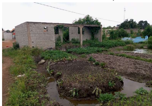
Photo 5 : Un terrain non aedificandi insuffisamment mis en valeur à Orly extension
