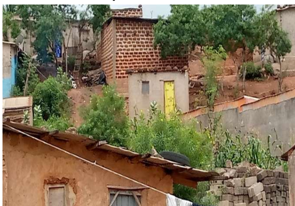
Photo 4 : Occupation anarchique du sol par les bâtisses à Kennedy extension
