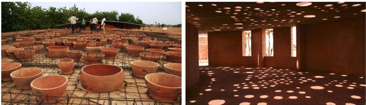
Figure 6 : Vue sur la toiture Bibliothèque de l'école de Gando de F. Kéré
