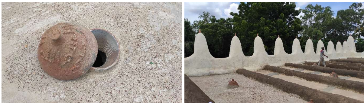
Figure 7 : Puit de lumière de la grande mosquée de Dioulassoba réhabilitée
